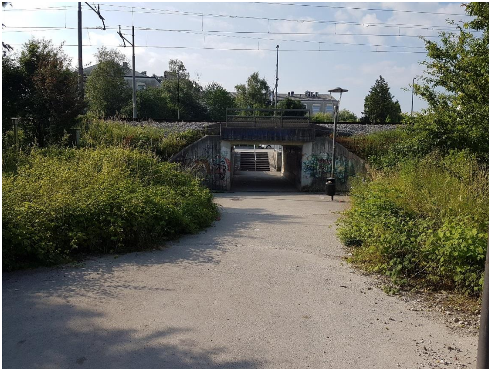
foto 11: podhod A11 (Fajfarjeva ulica).
