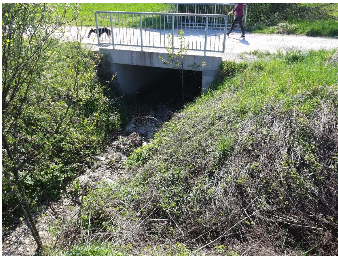
Foto 24: novi prepust na lokalni poti dolvodno od prepusta A15.
