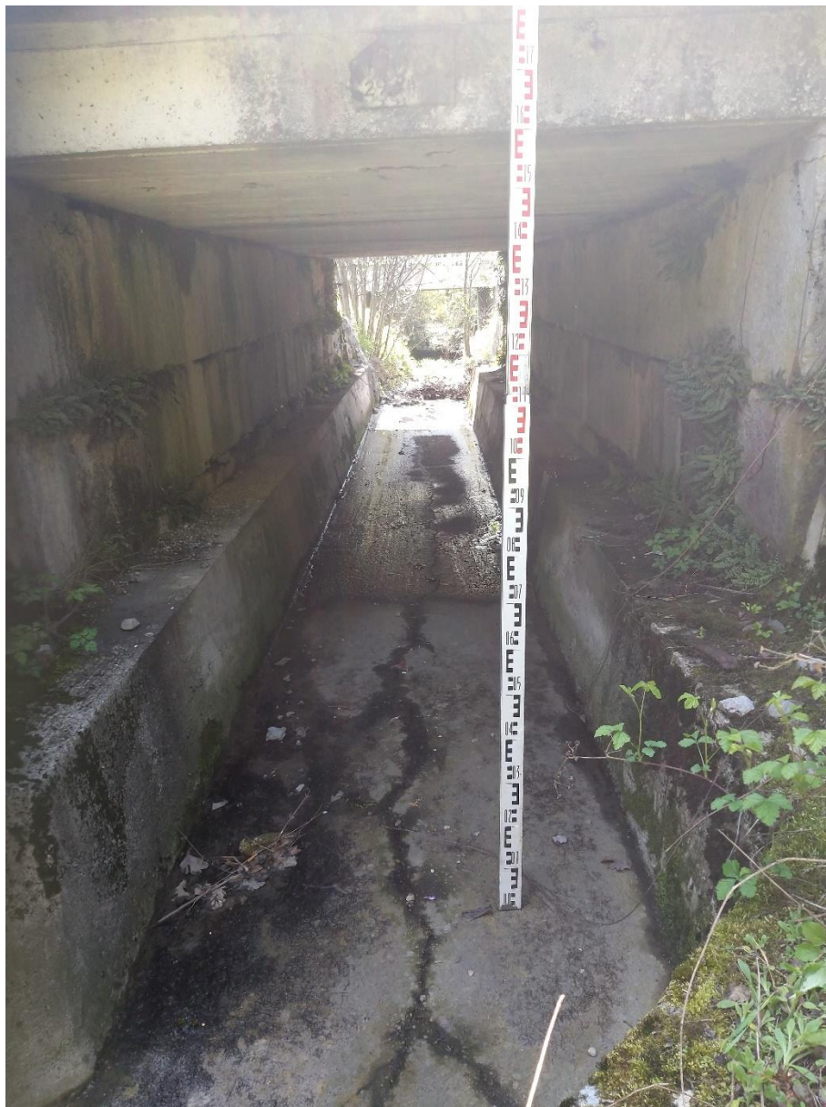
foto 22: prepust A15 – vtočna stran .
