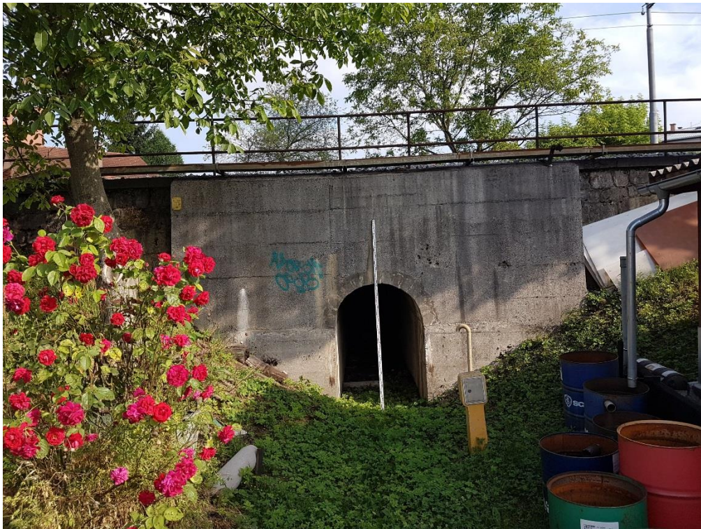
foto 9: podhod A9 (Fajfarjeva ulica).
